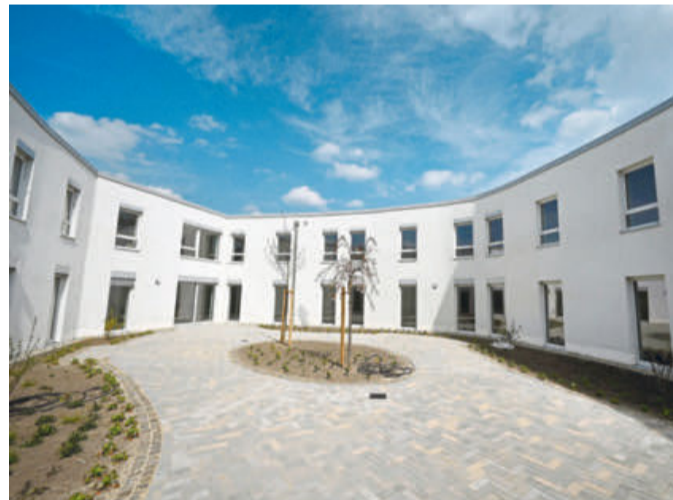
In jedem der beiden Gebäudeflügel gibt es einen in sich geschlossenen Innenhof. Foto: Oliver Schwabe
