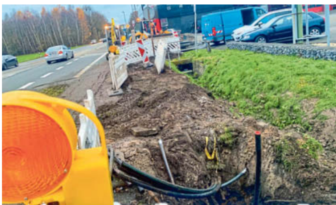
Die Bauarbeiten für die Leerrohre sind bereits auf das Gebiet Sennelagers vorgerückt.
