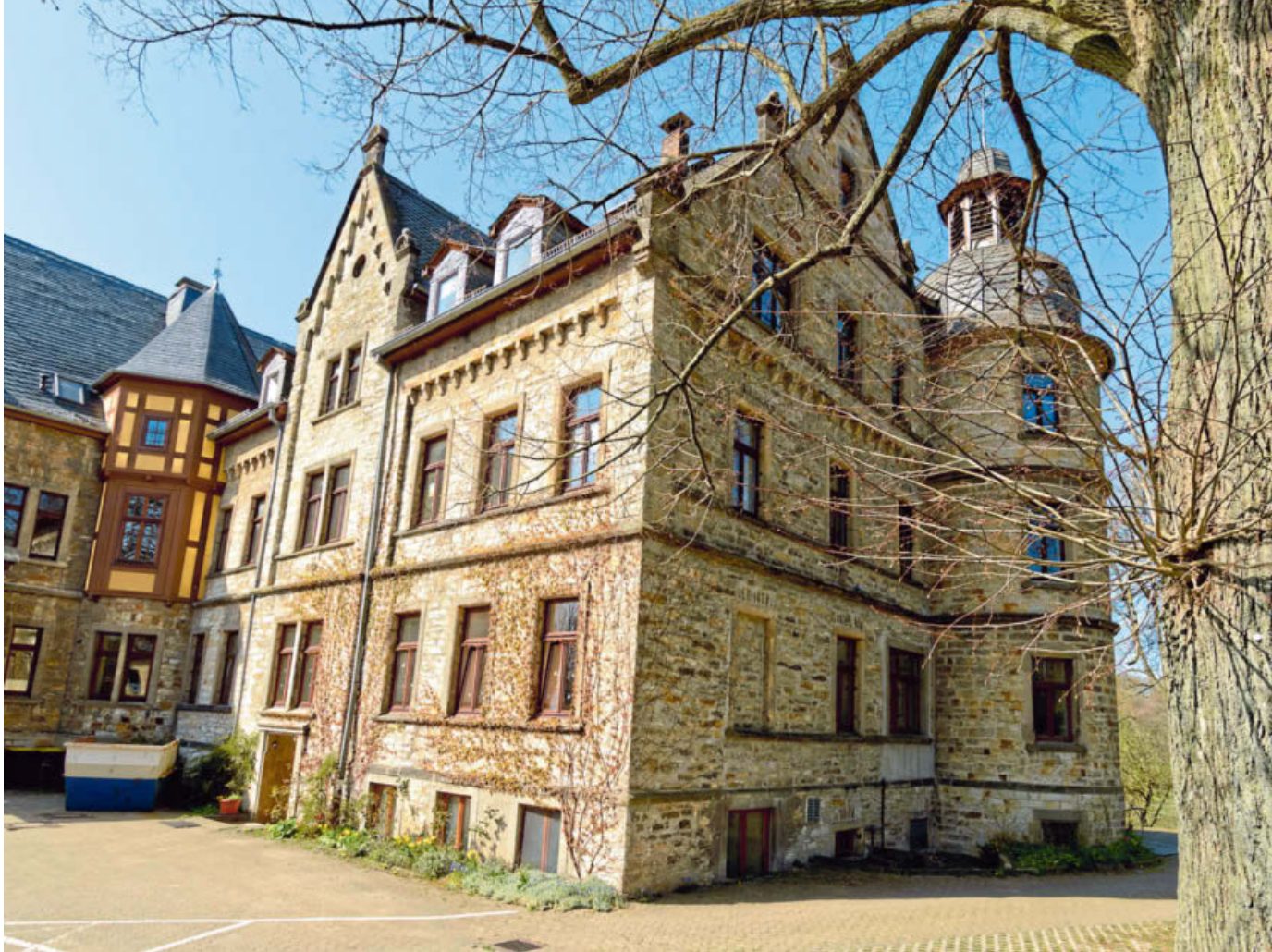
Seit 1947 wird auf dem Gelände von Schloß Hamborn eine Rudolf-Steiner-Schule betrieben.
