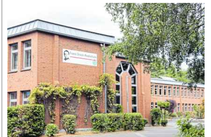
Für die dauerhafte Vierzügigkeit benötigt die Franz-Stock-Realschule in Hövelhof zusätzliche Räume.
