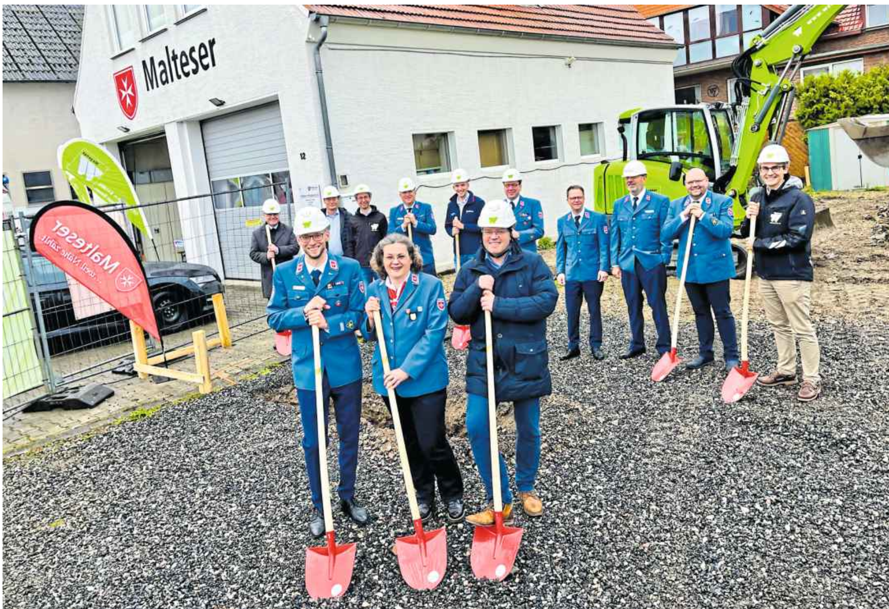
Neben der betagten Heimstatt der Borchener Malteser an der Wehrstraße wird der Anbau errichtet. Beim Spatenstich strahlen der Ortsbeauftragte Andreas Berlage (vorne, v. l.), die stellvertretende Diözesanleiterin Marion Frein von Graes und Bürgermeister Uwe Gockel gemeinsam mit Gästen und Verantwortlichen.
